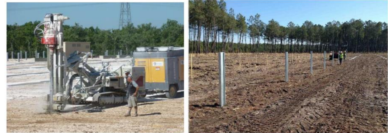
Figure 14 : Ancrage au sol par pieux battus (Source : Solvéo)
