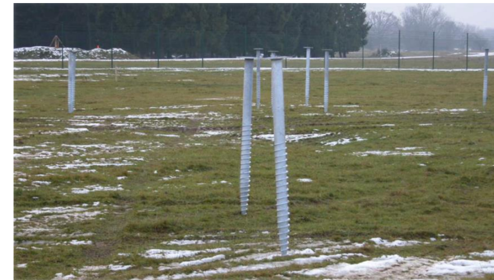
Figure 15 : Exemple de pieux vissés avant enfouissement (Source : Solvéo)
