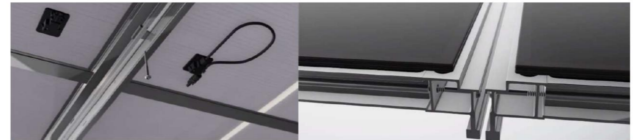
Figure 12 : Installation des modules entre eux (Source : First Solar)
